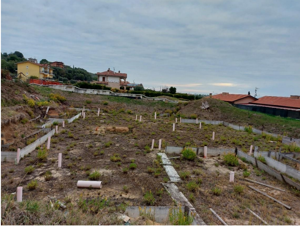
Vista lotti con picchettamento fondazioni costruzioni da edificare
