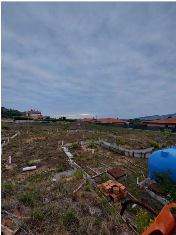
Vista lotti con picchettamento fondazioni costruzioni da edificare
