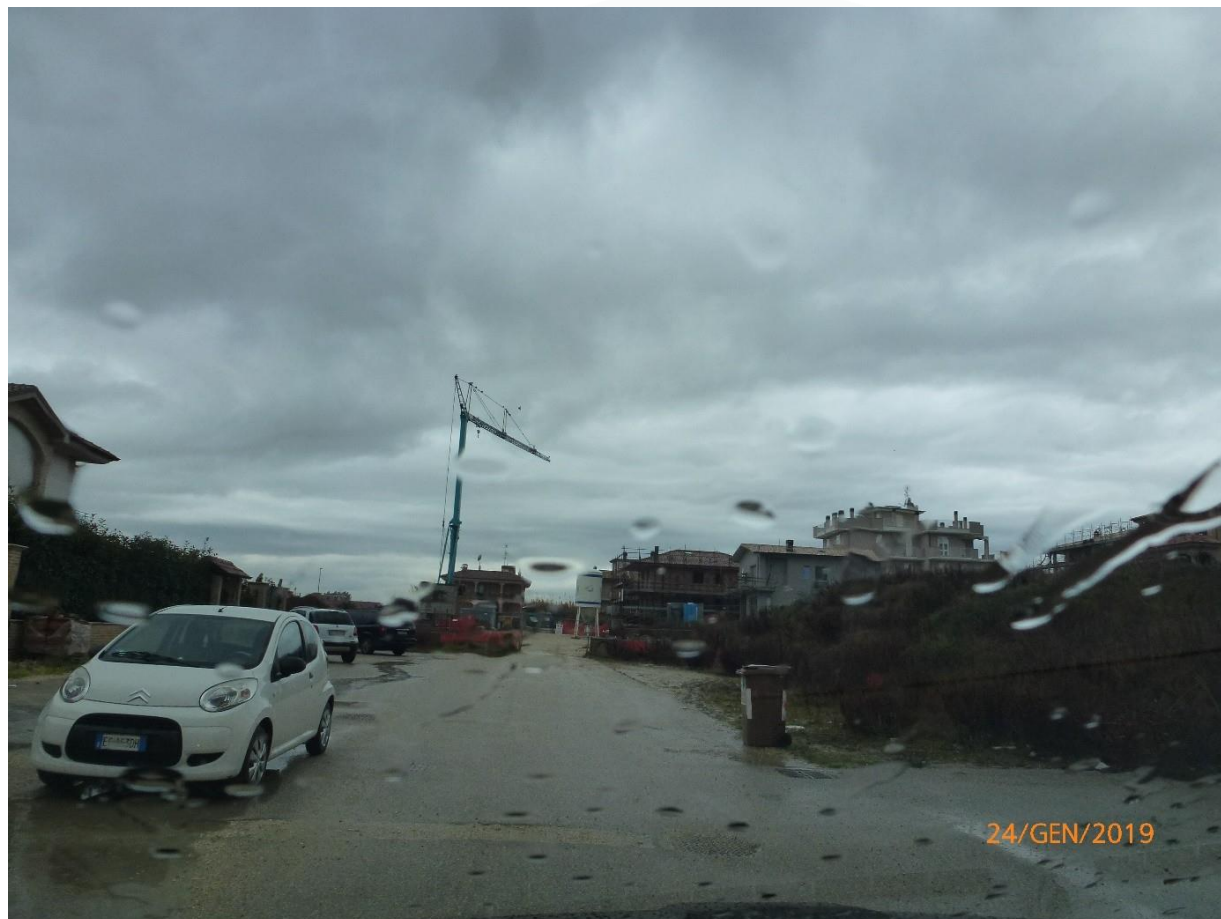
Strada di lottizzazione via Montale
